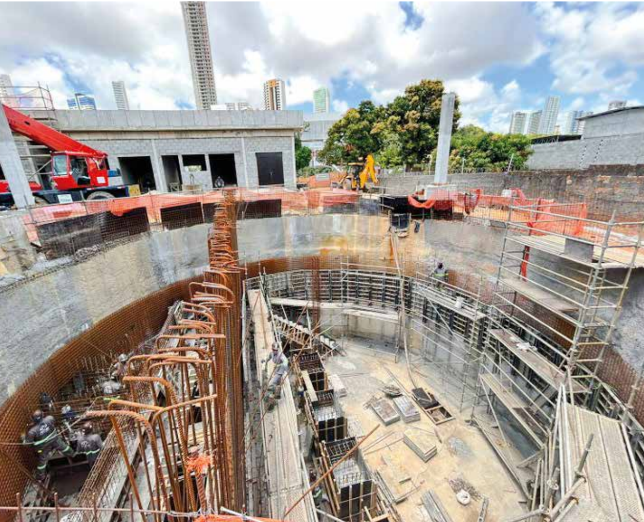
Intervenção que modernizará o sistema de esgoto da Grande João Pessoa alcançou 75% de execução e deve ser concluída em 2026
